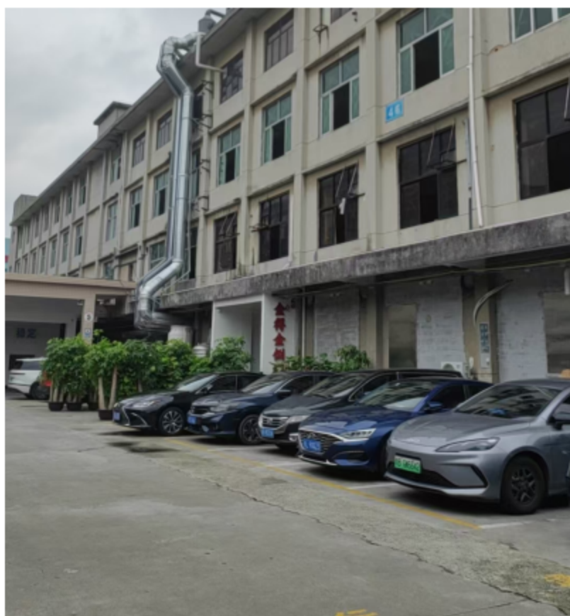
图 3-5 厂区地面硬化情况
