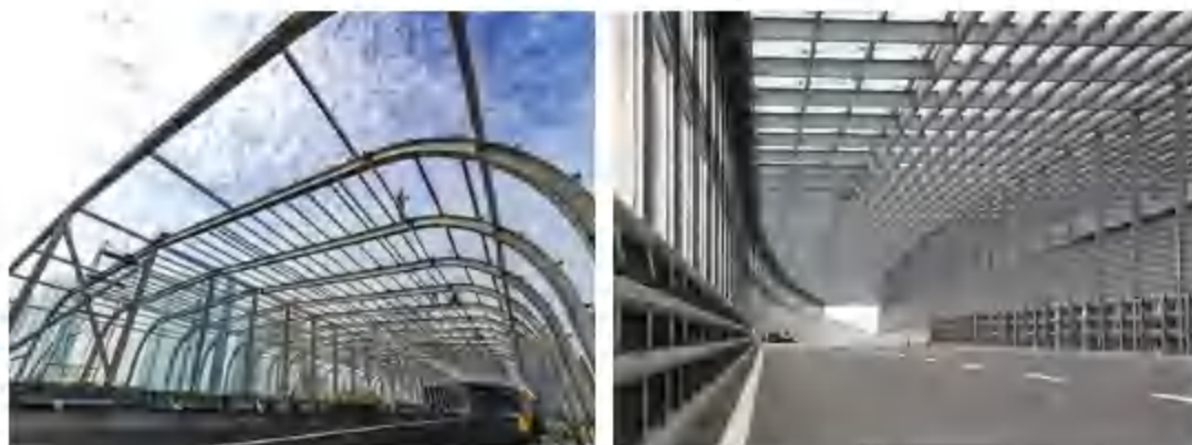
图 6-3 全封闭式声屏障工程示例图
