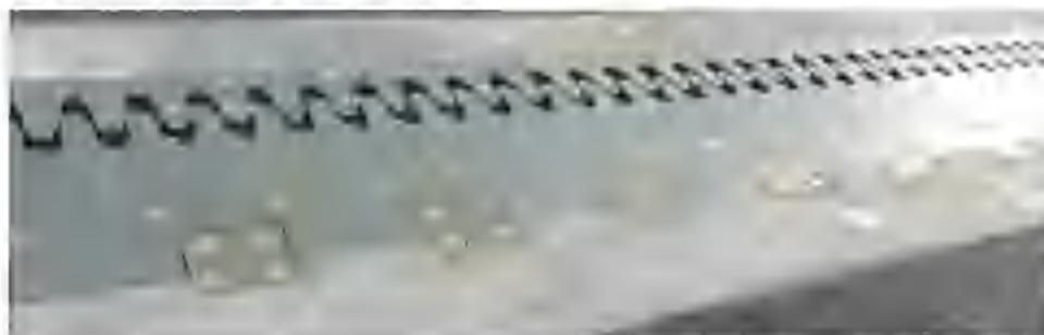
图 6-1 降噪型伸缩装置工程实例图
