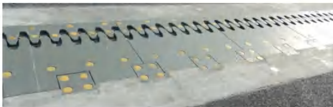
图 6-1 降噪型伸缩装置工程实例图
