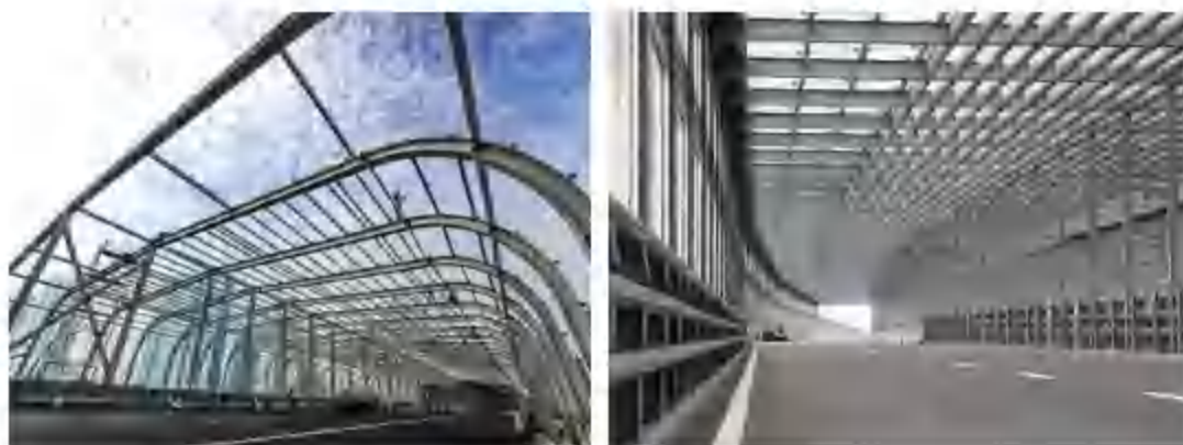
图 6-3 全封闭式声屏障工程示例图
