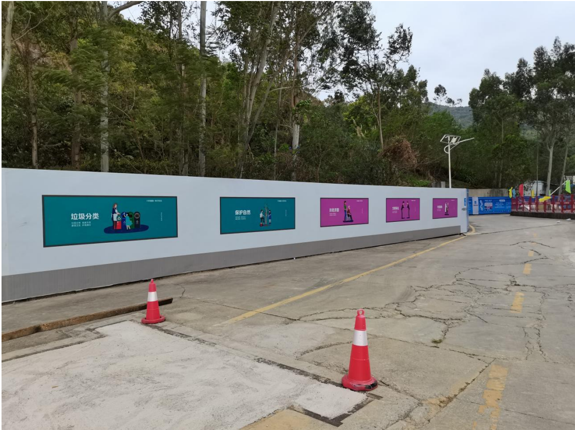
图 5.3-1 施工期围挡措施
