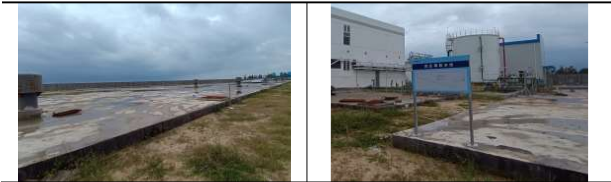
图 4.1-4 事故应急池现场照片
