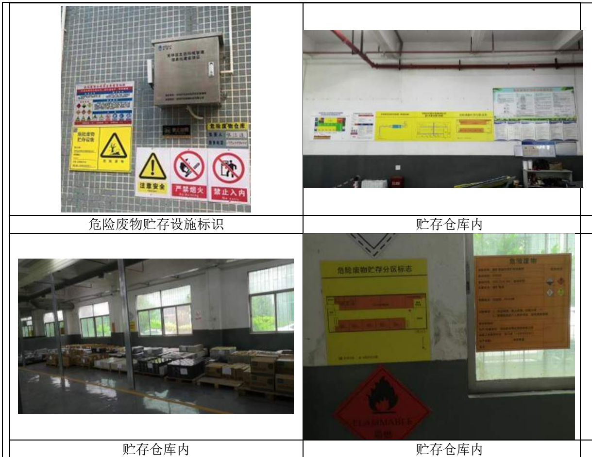
图3-1 项目危险废物仓库
