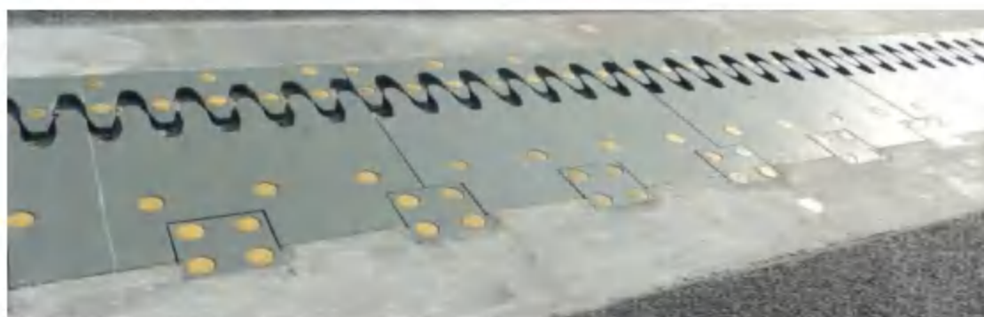
图 6-1 降噪型伸缩装置工程实例图
