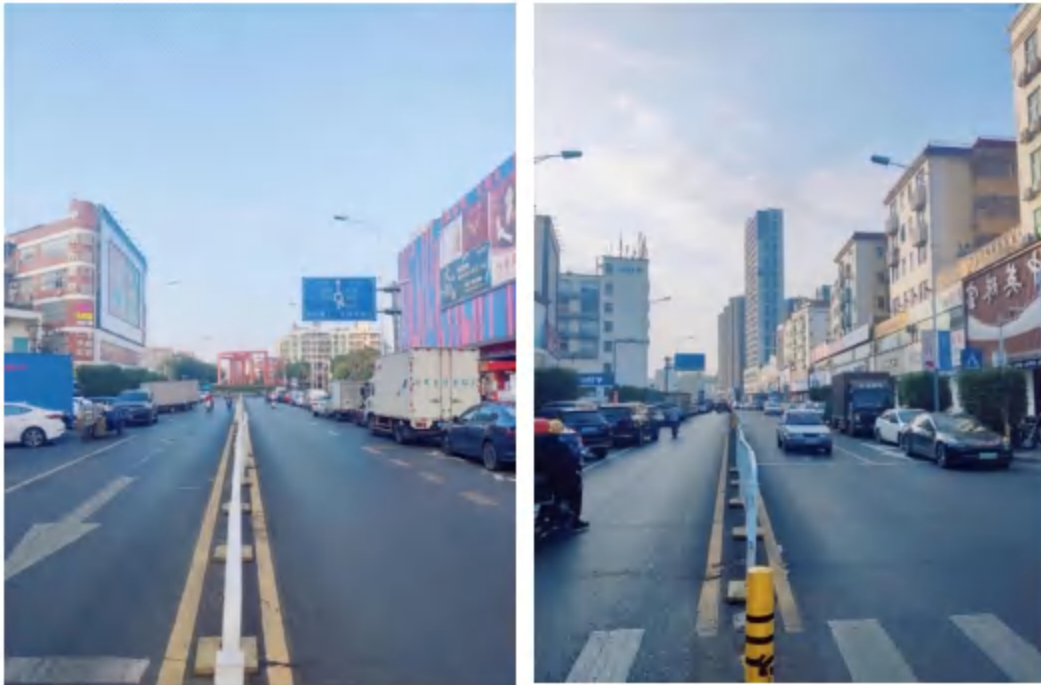
图 3-2 项目道路现状照片
