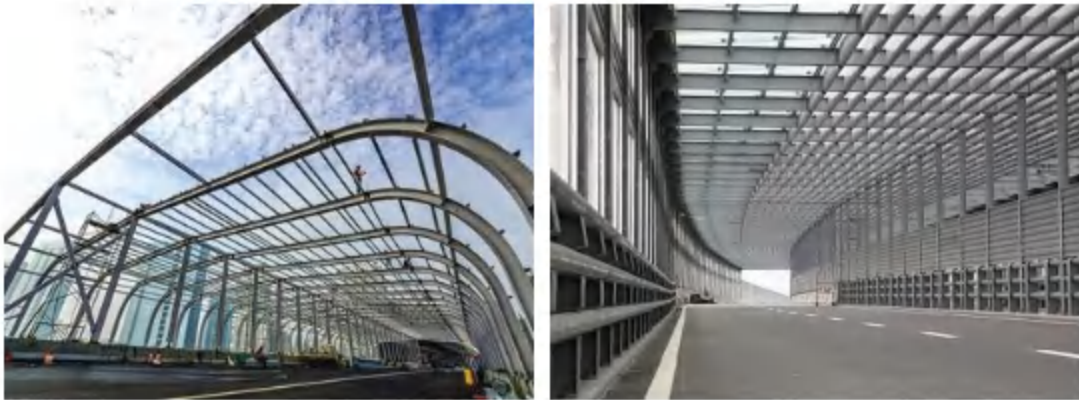
图 6-3 全封闭式声屏障工程示例图
