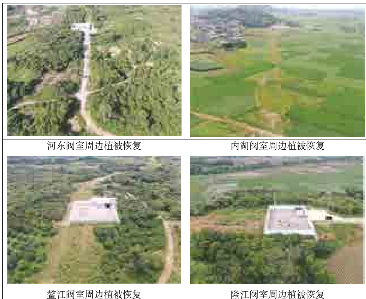
图 5.2-2 站场、闸室植被恢复情况
