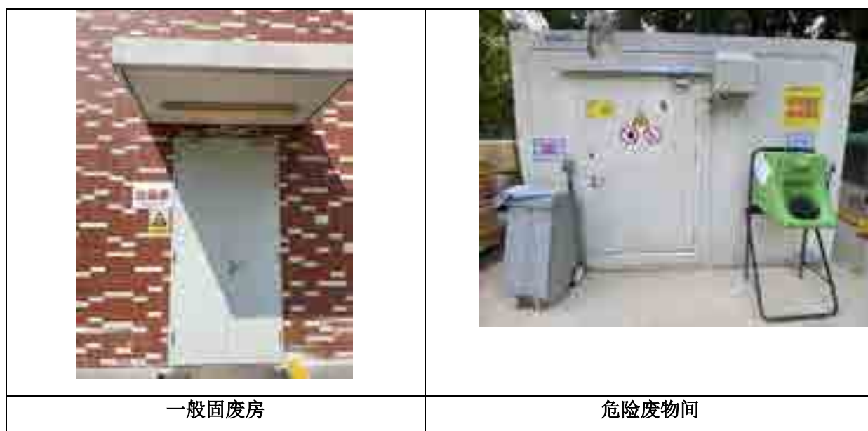
图 4.1-5 危废暂存车间照片
