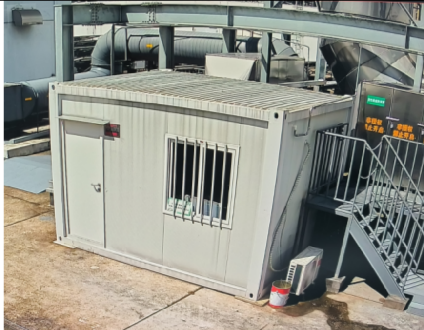
图 4-1 日东光学生产废气总排口 (DA001) 在线监测室
