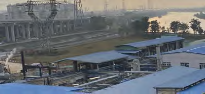
项目南侧工业厂房
