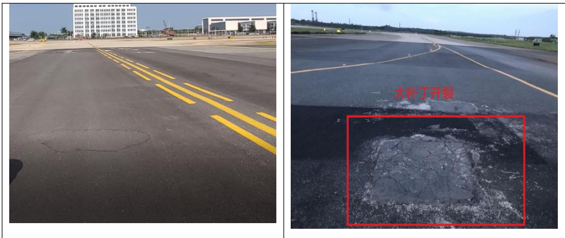
图 3-1 项目现状照片
