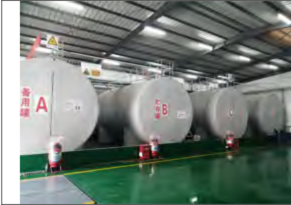
厂房现状（废矿物油贮存间）
