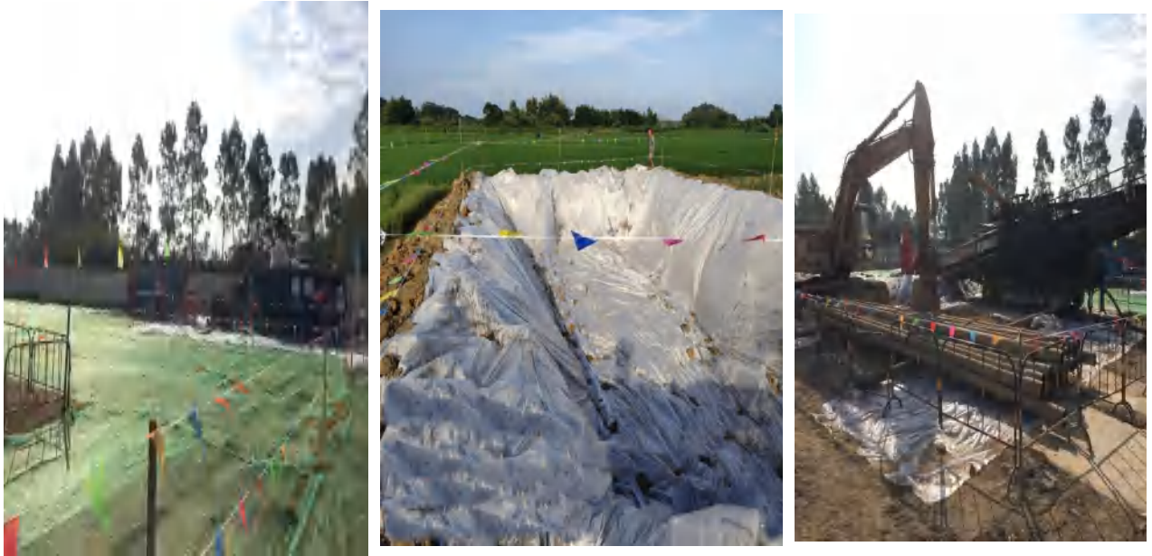
图 5.3-2 定向钻施工环保措施
