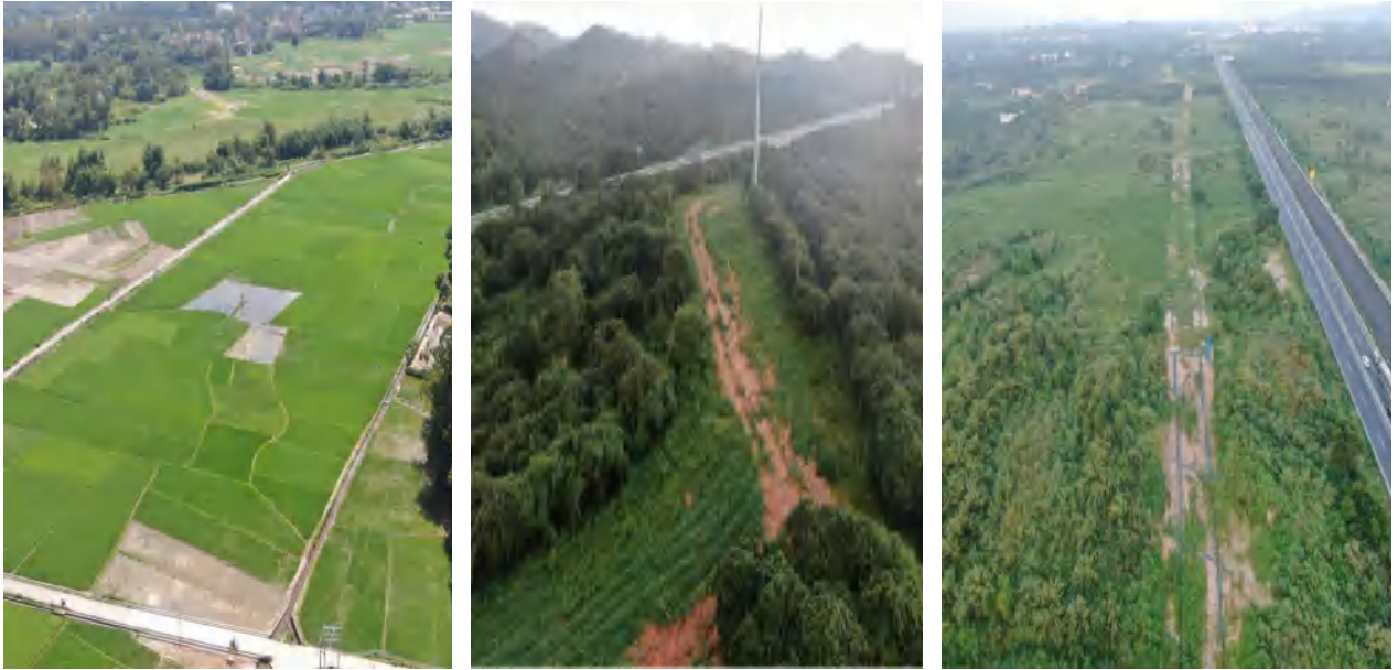
图 5.3-1 管道沿线生态恢复情况
