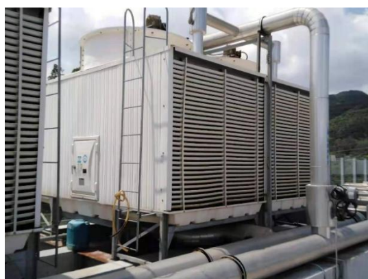
冷却塔设置于楼顶、山顶，减振
