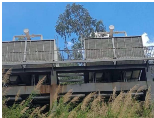
冷却塔设置于楼顶、山顶，减振
