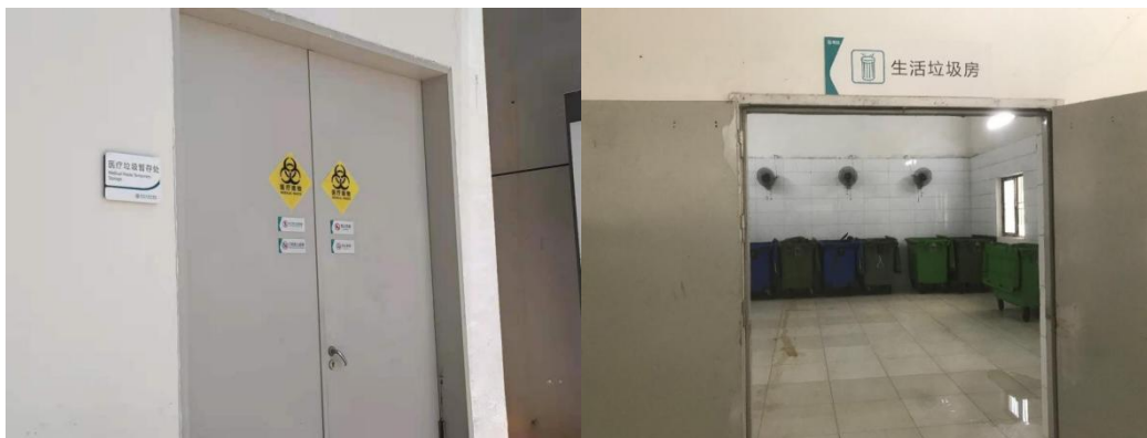
图 4-5 固体废物暂存场所图片
