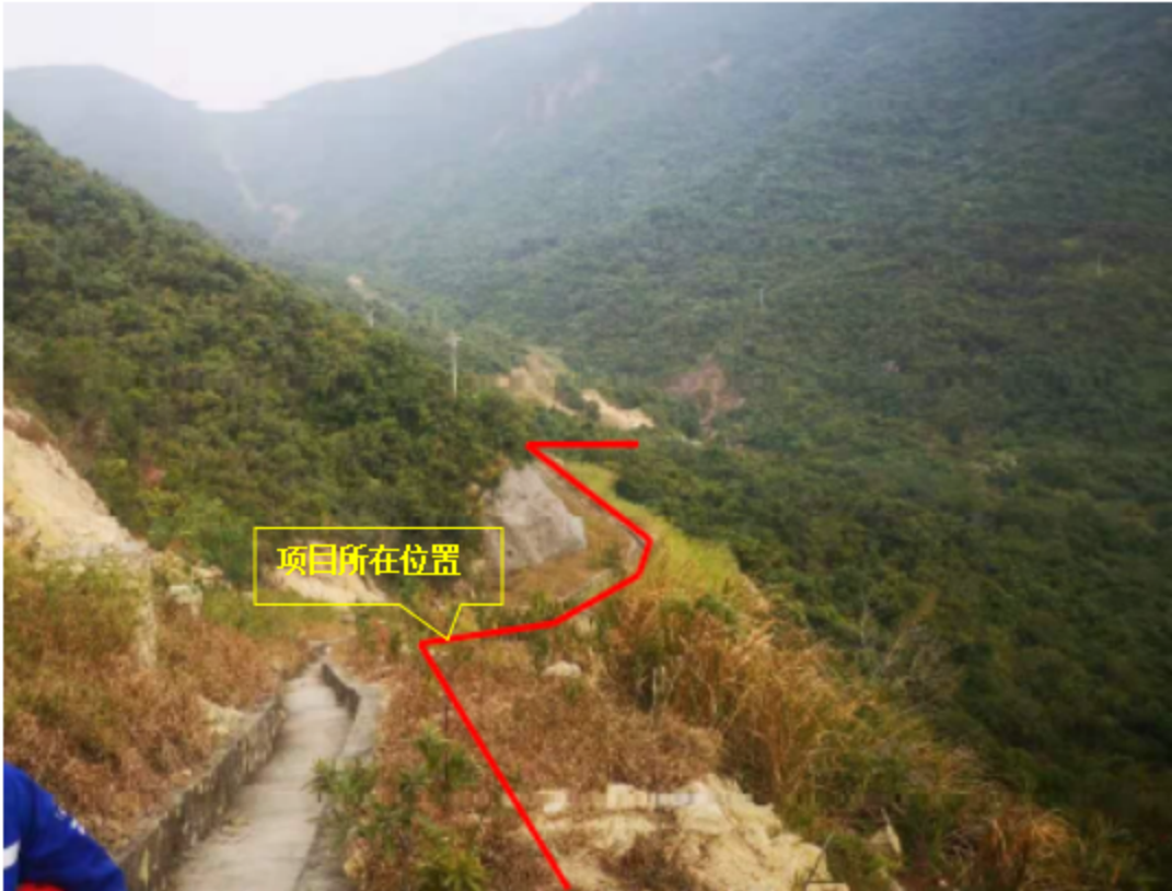
图 2-1 项目所在位置现状照片
