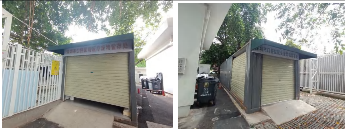
图 3-5 医疗废物暂存处和生活垃圾暂存处图片
