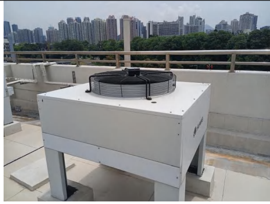
室外机的基础减振
