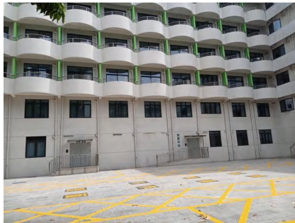
图 3-7 隔声窗安装落实情况
