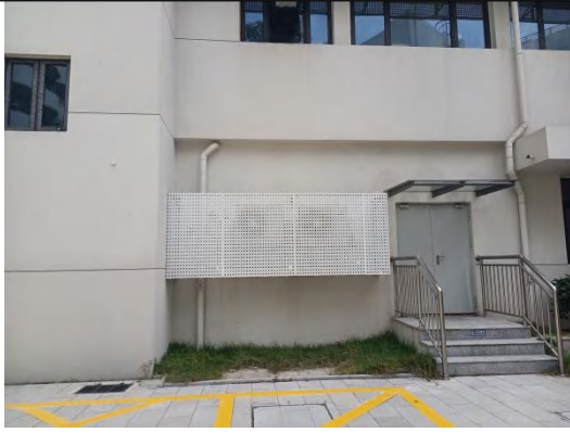
室外机设置隔声板
