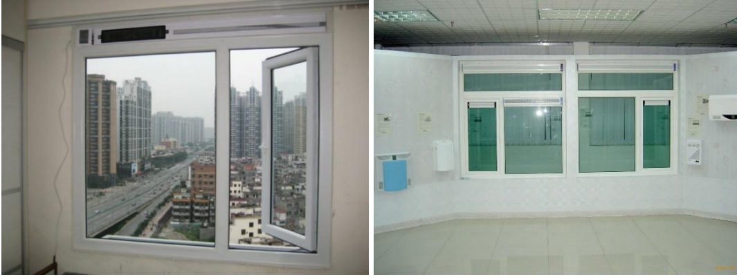
图 6.2-5 通风隔声窗应用实例
