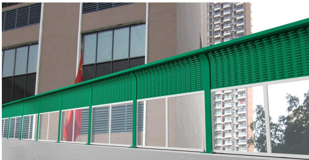
图 6.2-2 直立式声屏障工程实例图
