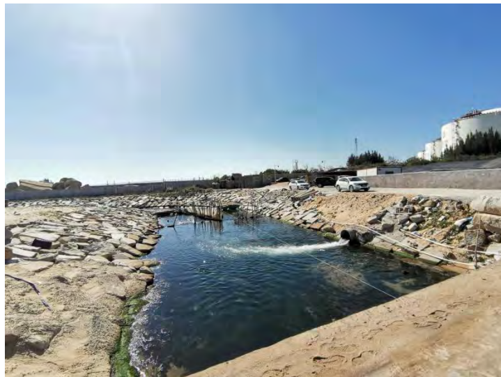
图 3.2-4 养殖排水口现场照片
