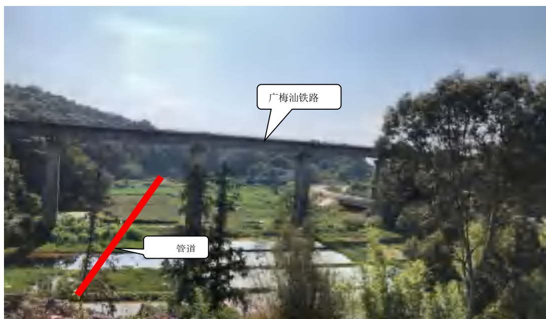
图 3.4-12 广梅汕铁路穿越现场照片
