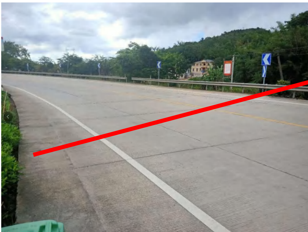
图 3.4-10 G206 国道穿越现场照片
