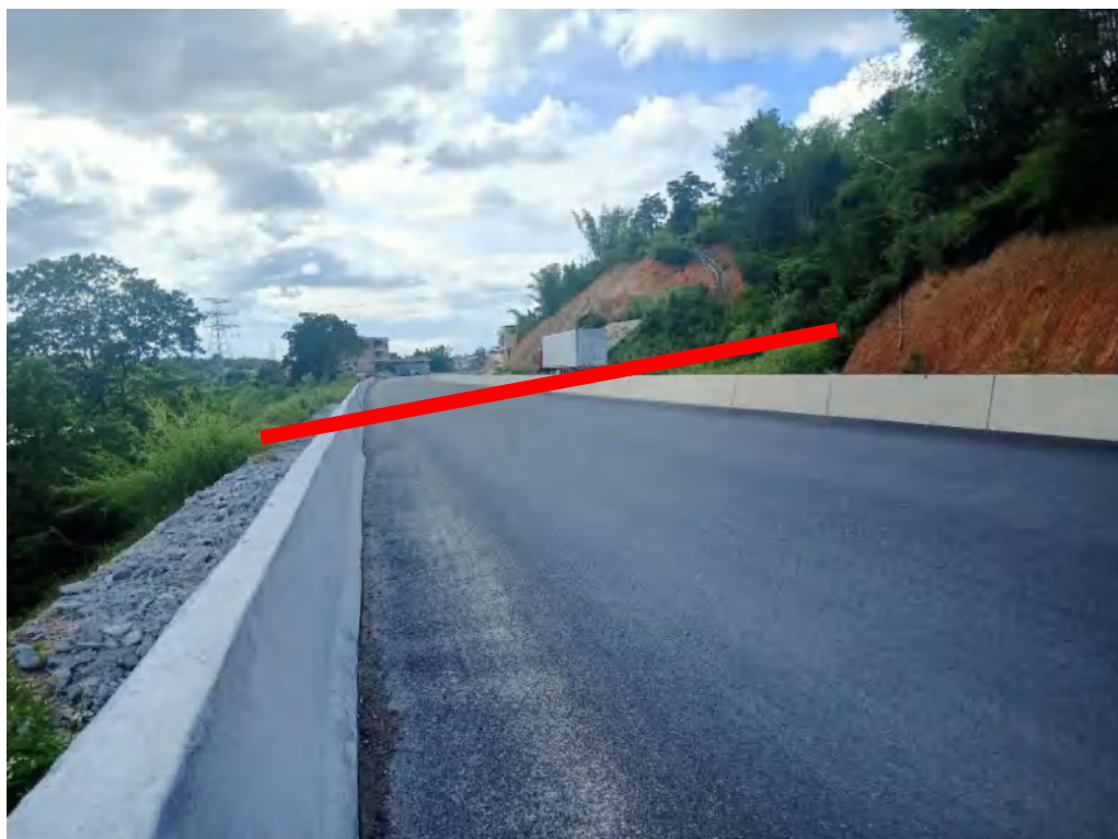
图 3.4-8 S225 省道穿越现场照片
