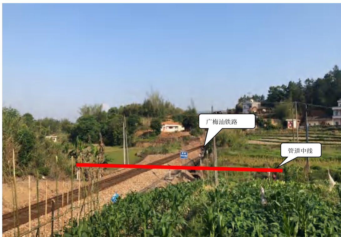
图 3.4-13 广梅汕铁路穿越现场照片
