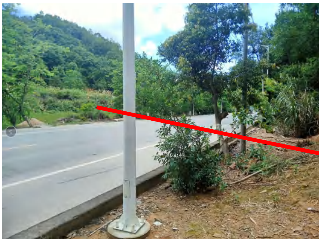
图 3.4-5 G205 国道穿越现场照片
