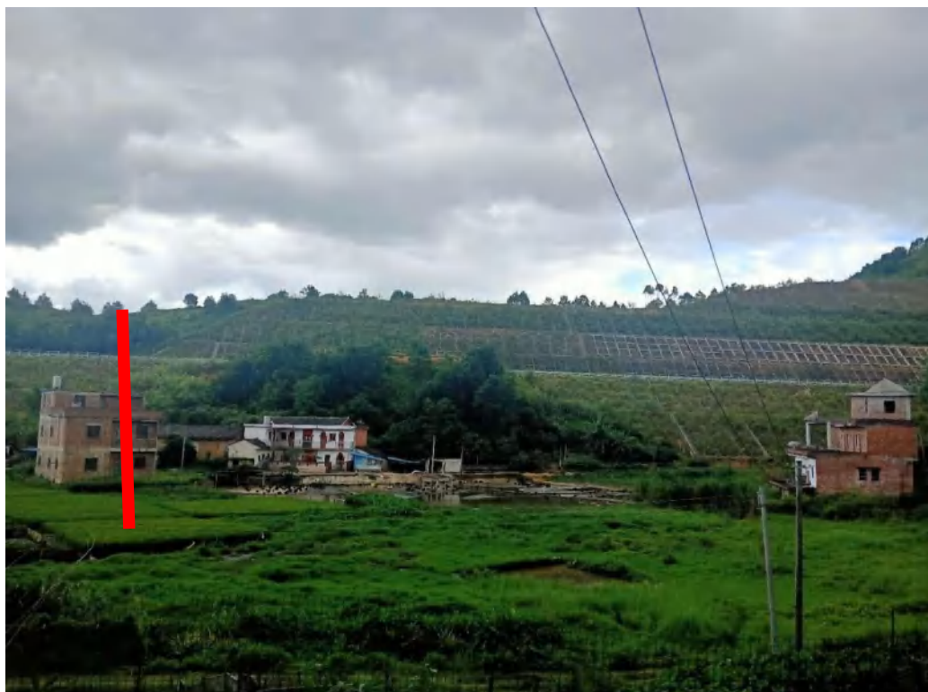
图 3.4-9 S19 兴华高速穿越现场照片
