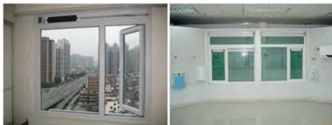
图 7.2-6 通风隔声窗应用实例
