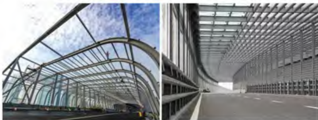
图 7.2-4 全封闭式声屏障工程示例图
