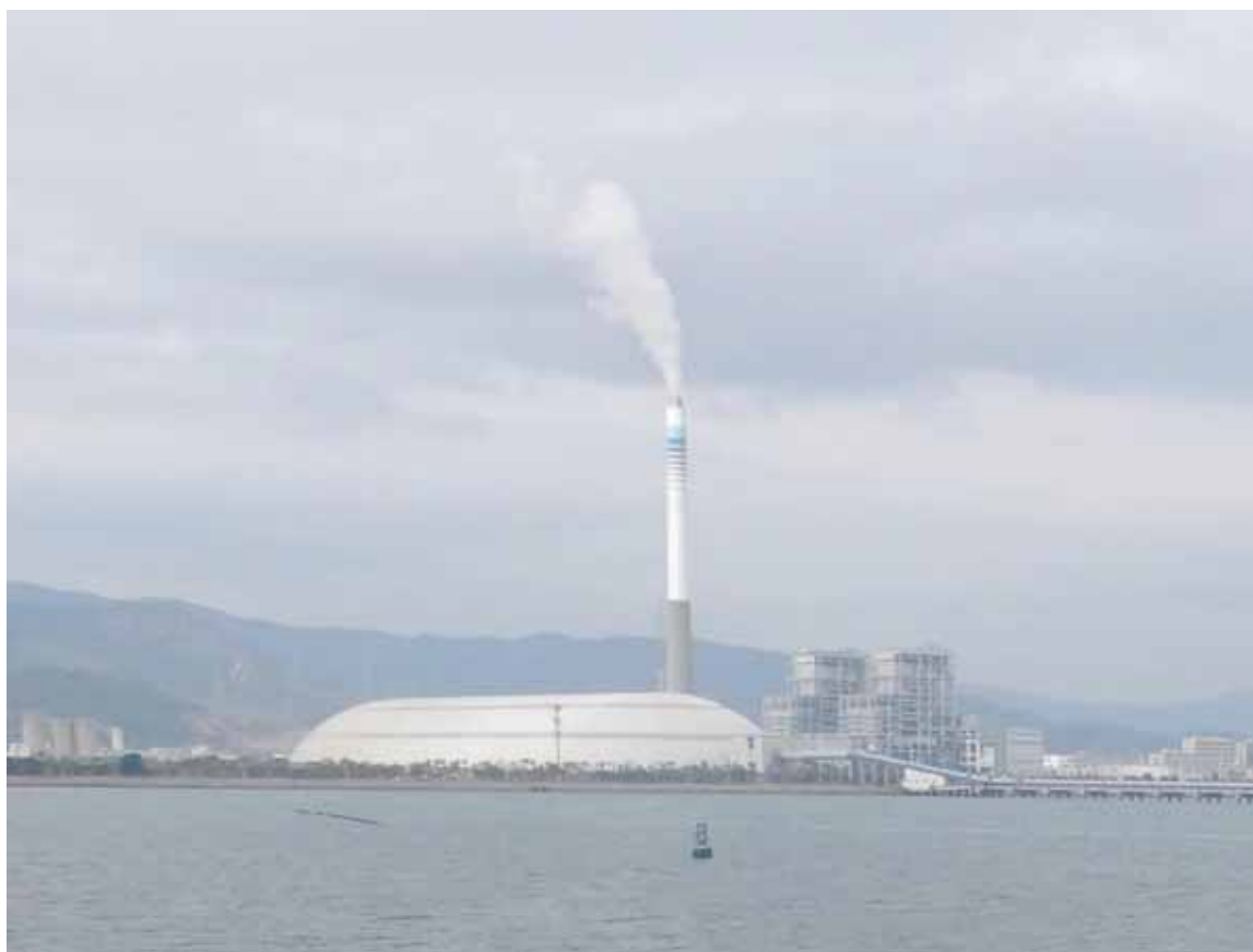
图 5.4-3 广东国华惠州大亚湾热电一期 2×300MW 机组工程现状图（一）
