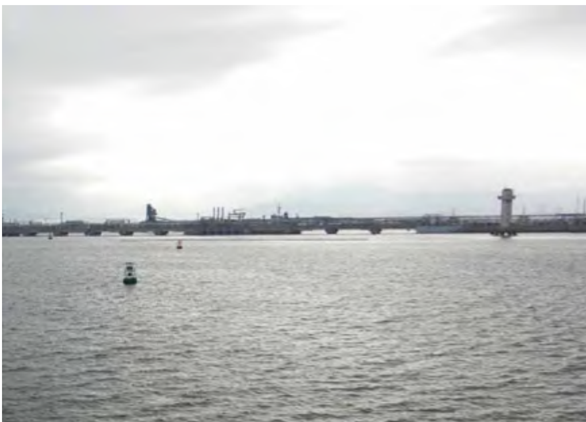
图 5.4-5 中海壳牌东联石化码头现状图
