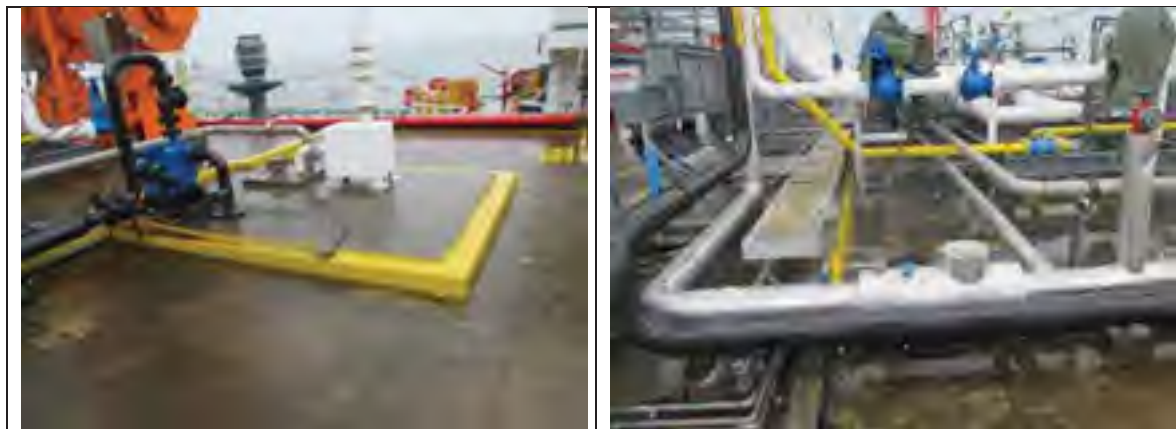
图 3.5-1 码头现有工程围堰设置情况
