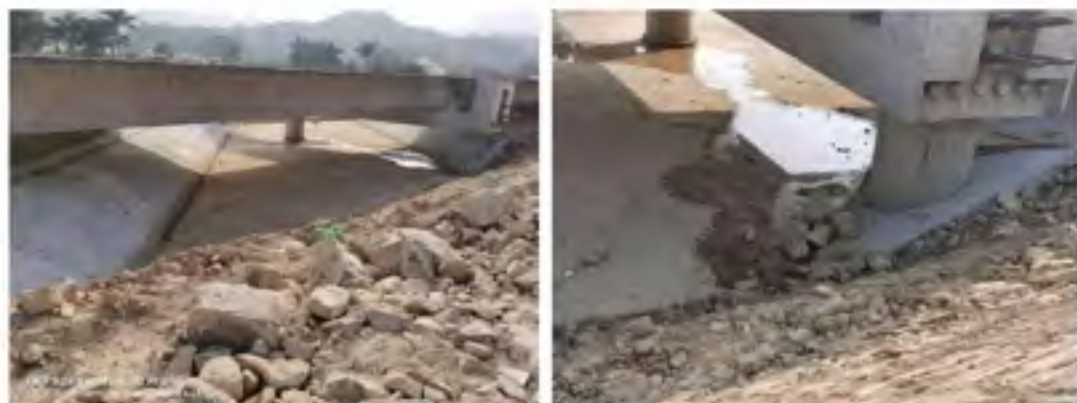
图 7-1 江屋山水跨河桥现场施工情况
