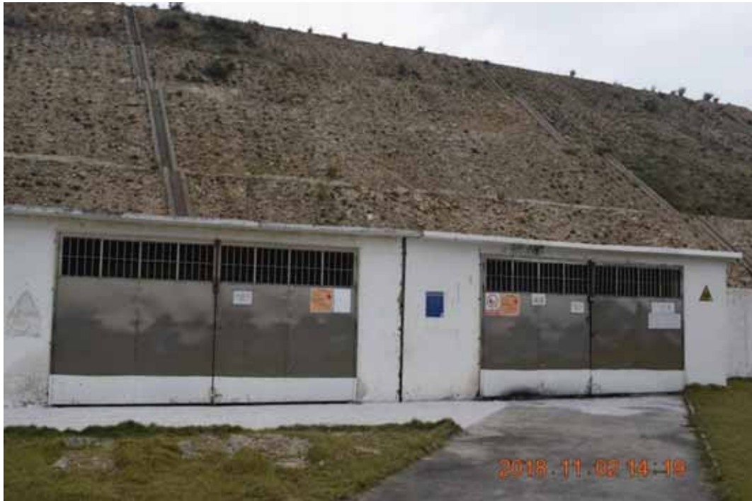
中化珠海铁炉湾库区危险废物暂存库
