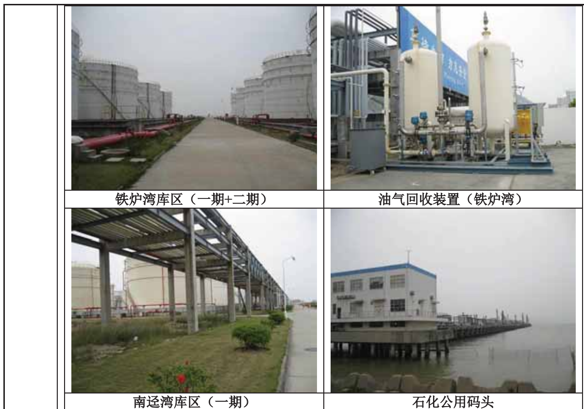
图 2-1 库区及码头项目建设现状
