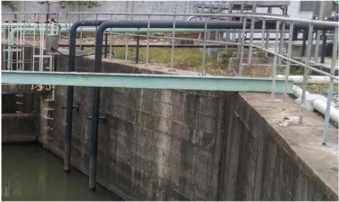
图 3.6-7 雨水总排口处安装的管道
