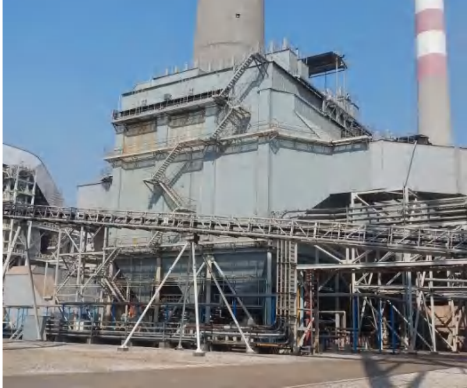
图 3.6-12 电袋复合除尘器
