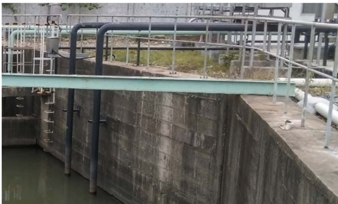
图 3.6-7 雨水总排口处安装的管道
