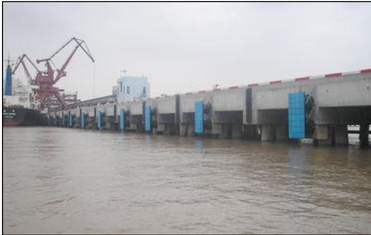
图 6-1 橡胶护舷示意图
