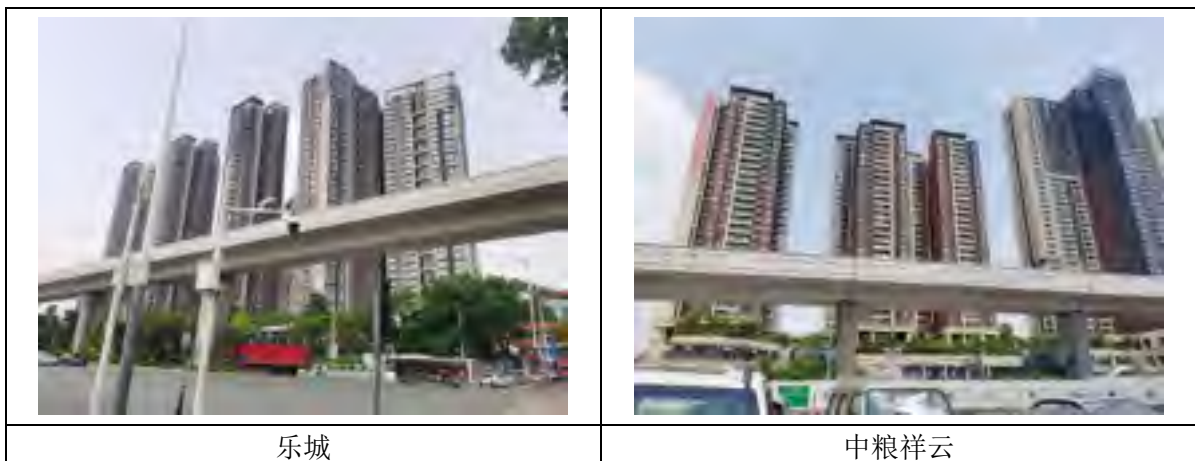
图 1-41 项目起终点段道路现状
