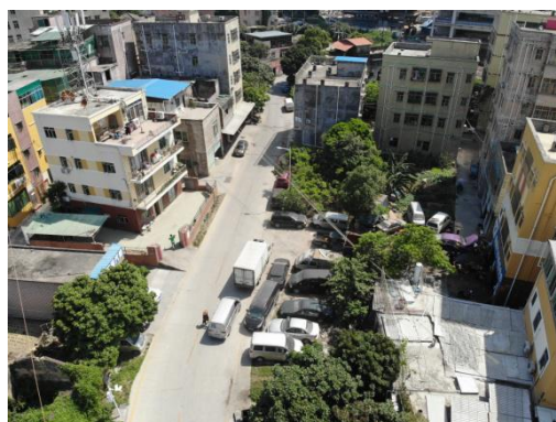
现状道路沿线
