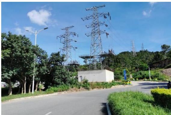
道路终点处两座铁塔
