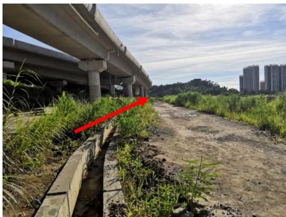
立交桥下道路场地
