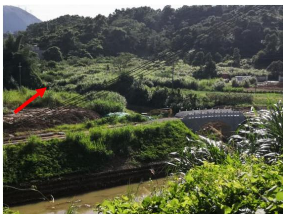
现状汤坑水河道
