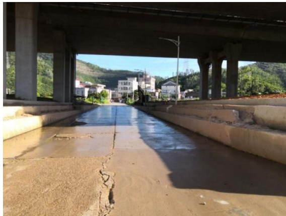
现状南坪快速路桥下
