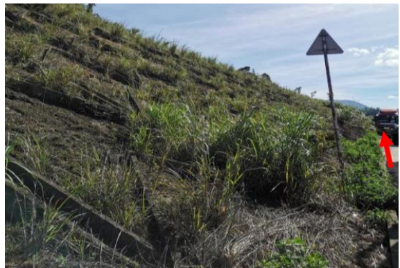
道路南侧现状坡面
