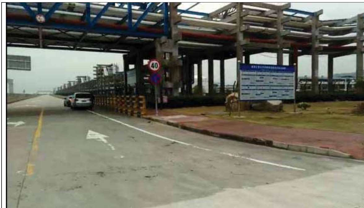
现有管廊（南迳东路-平排四路）
