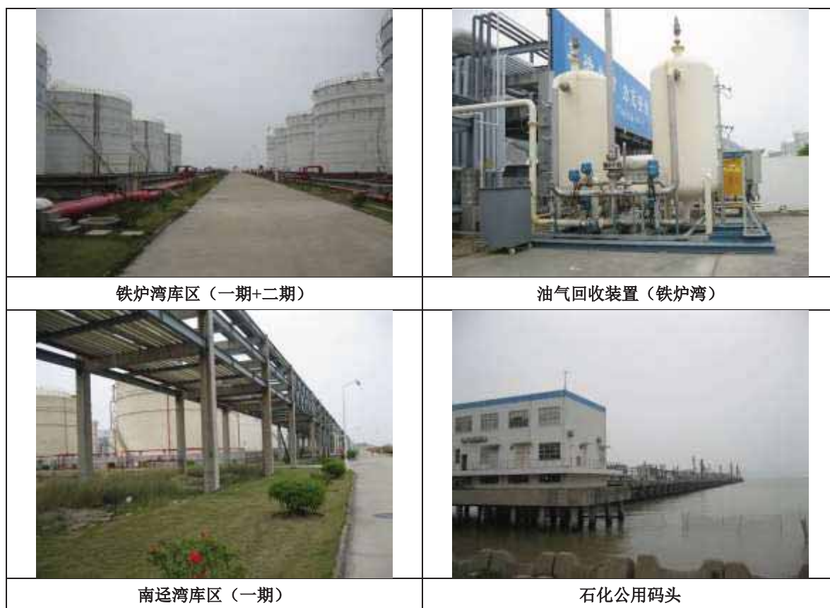
图 3.1-1 中化珠海库区及码头项目建设现状
