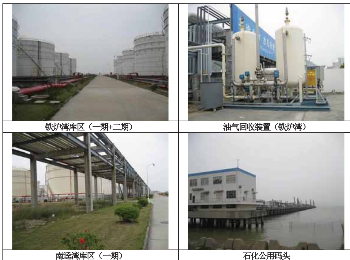
图 1-1 库区及码头项目建设现状
