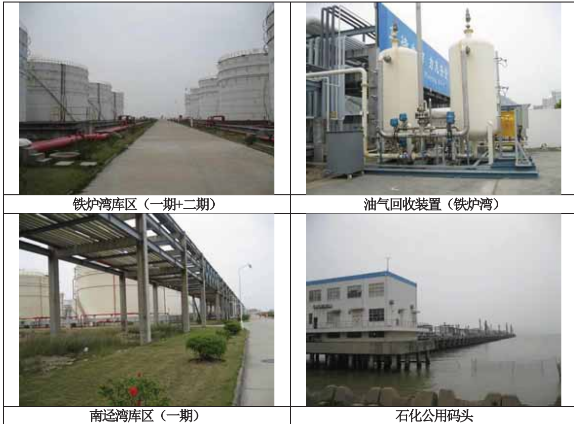
图1 库区及码头项目建设现状
