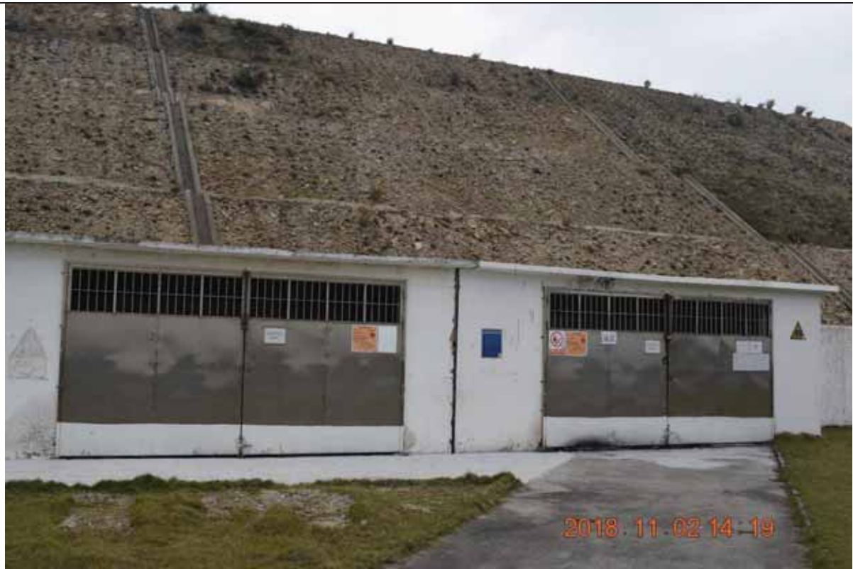
图 5 铁炉湾库区危险废物暂存库现场照片
