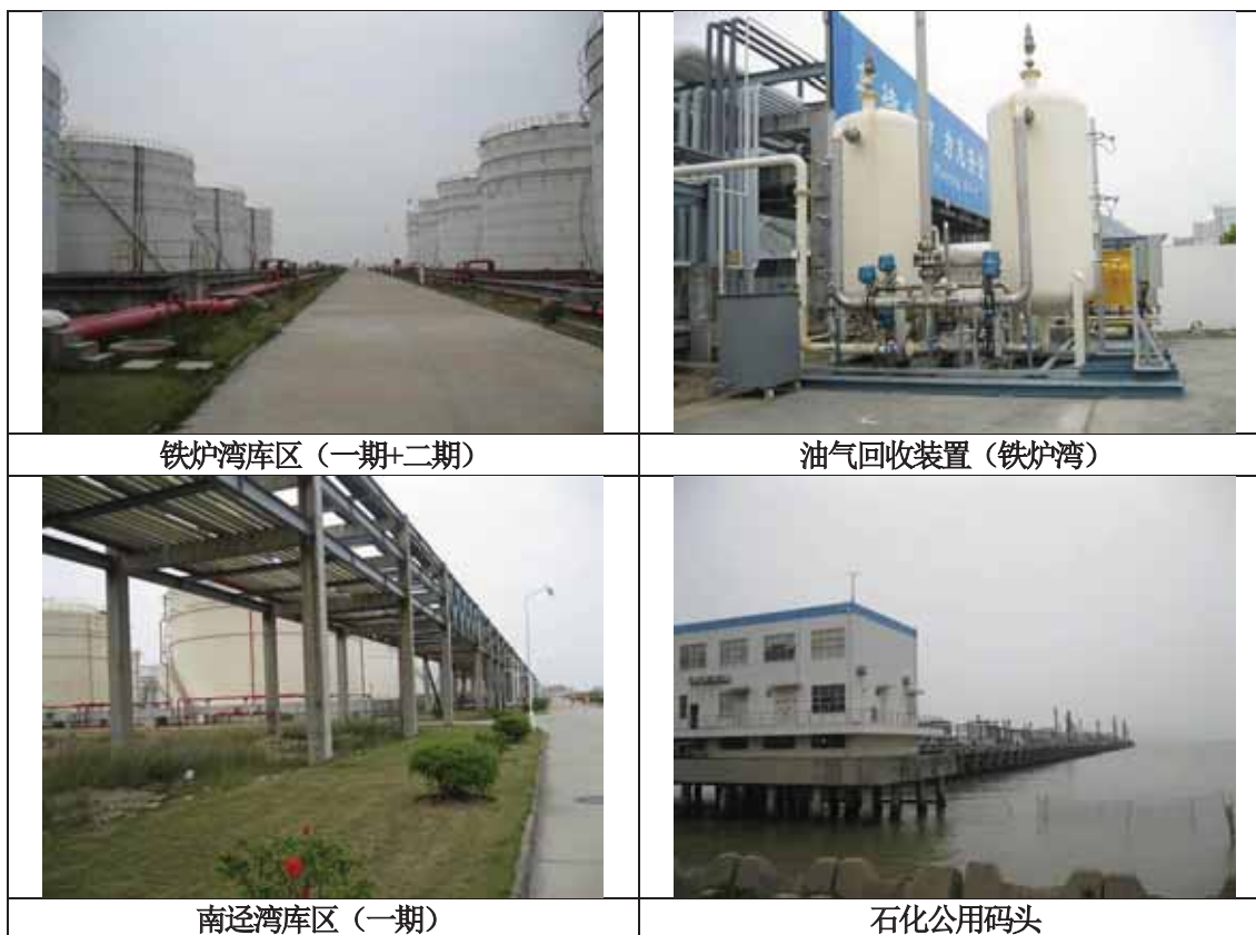
图 1.1-1 库区及码头项目建设现状
