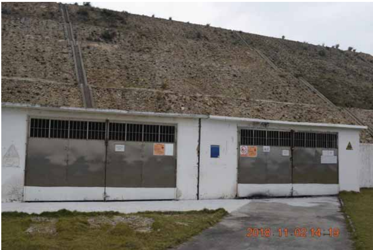
图 4 铁炉湾库区危险废物暂存库现场照片
