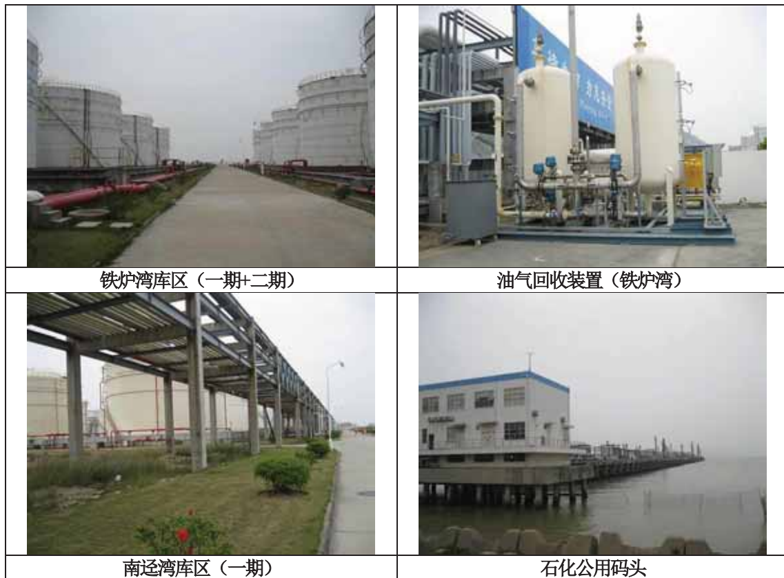
图1 库区及码头项目建设现状
