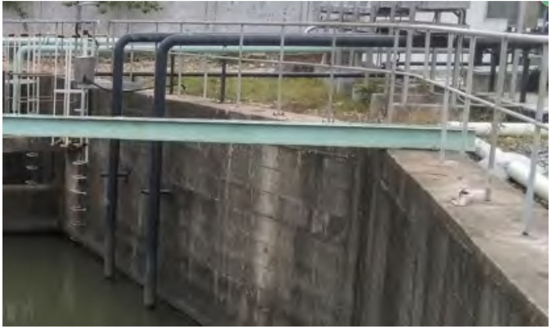
图 3.6-7 雨水总排口处安装的管道
