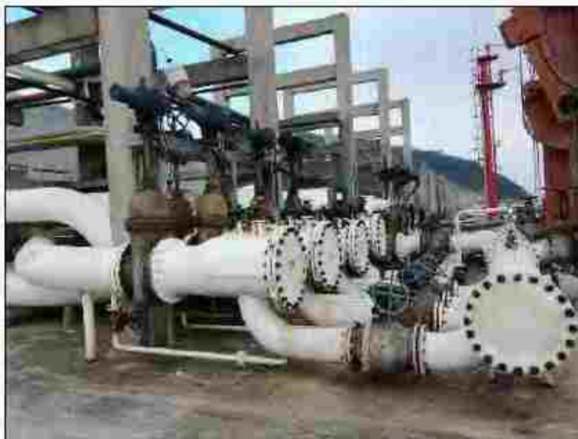
图 3.2-7 码头现有工程管线布置现状照片
