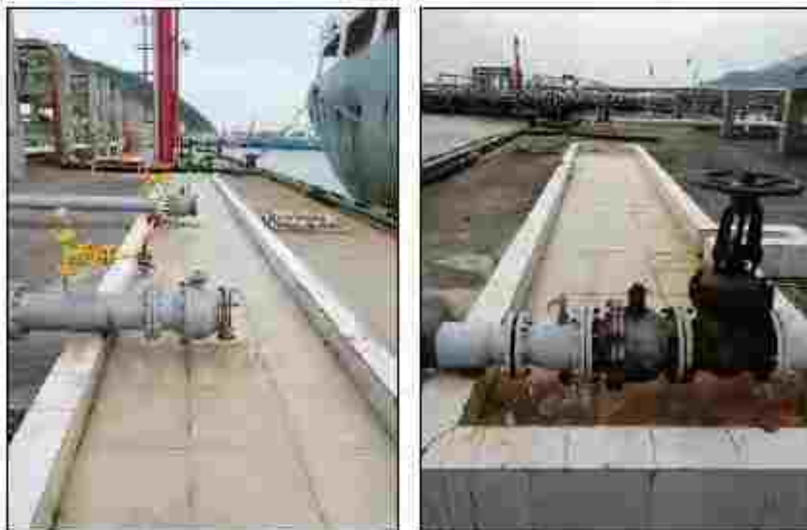
图 3.5-1 码头现有工程围堰设置情况
