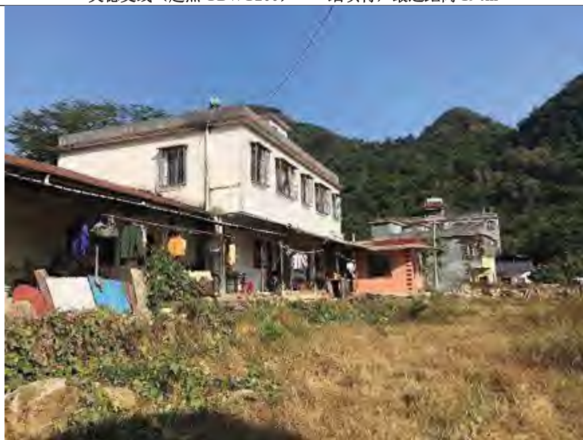
英德支线（YBWY220- YBWY229）——坑头村，拆迁后最近距离 19.5m
