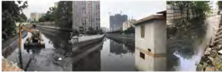
图 3-8 茅洲河汊流、排洪渠主要节点现状
