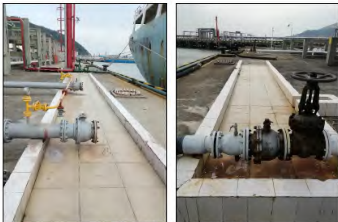
图 3.5-1 码头现有工程围堰设置情况
