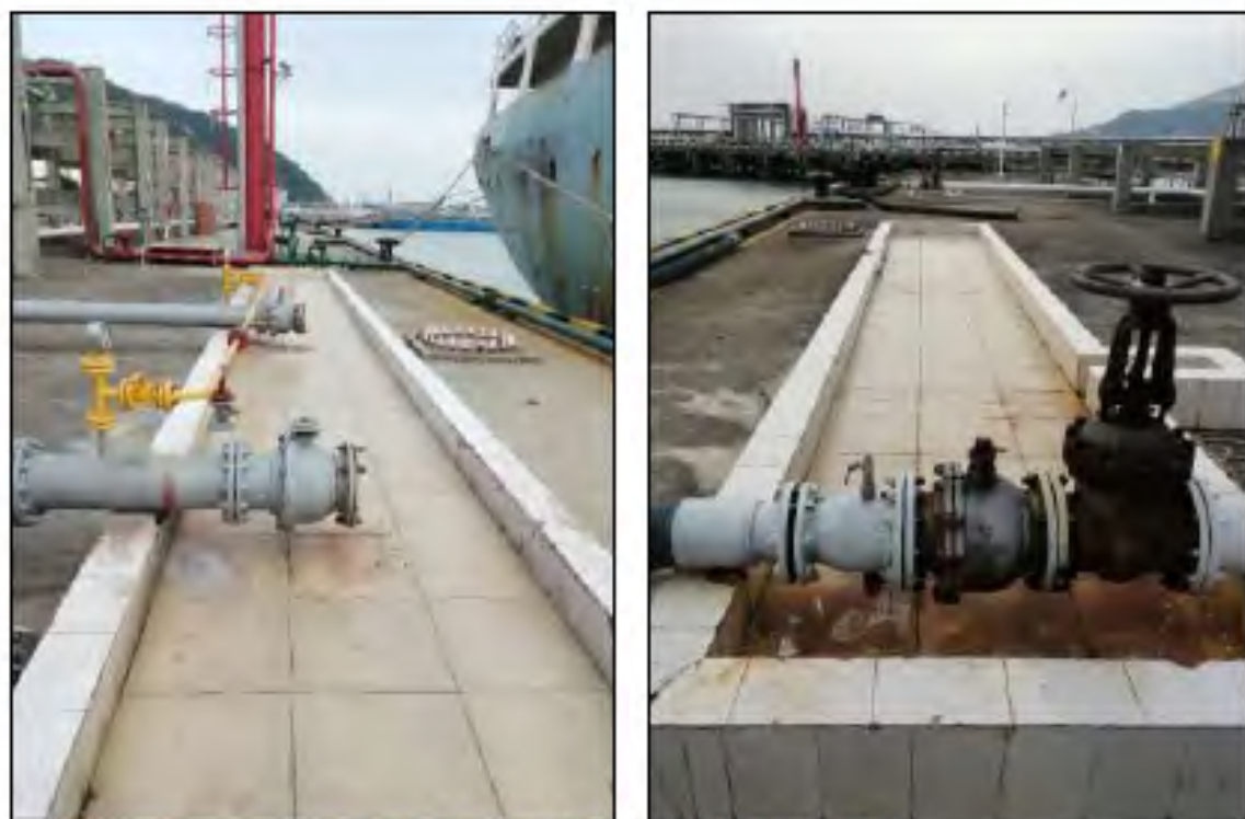
图 3.5-1 码头现有工程围堰设置情况
