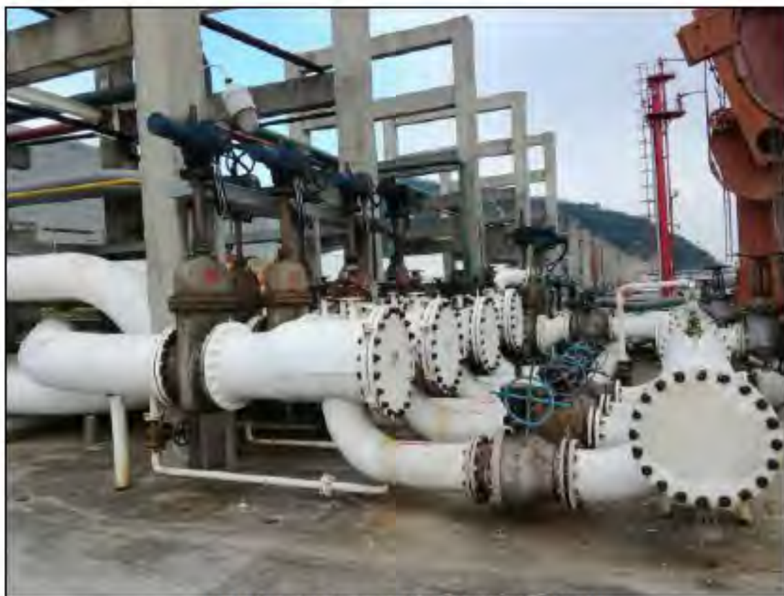
图 3.2-7 码头现有工程管线布置现状照片
