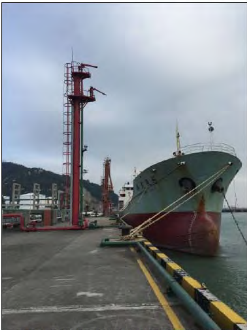
图 3.2-4 码头现状照片（自北向南拍摄 拍摄地点：项目北端）
