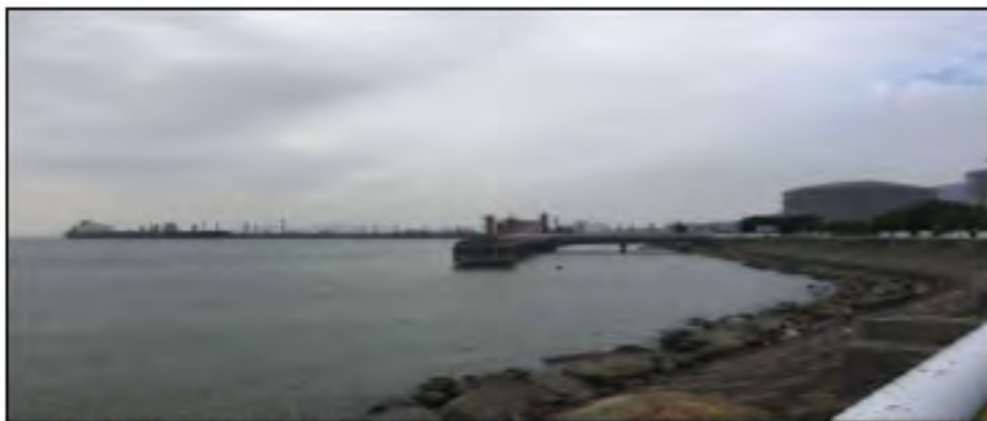
图 3.2-3 码头现状照片（自南向北拍摄 拍摄地点：项目南办公楼前）
