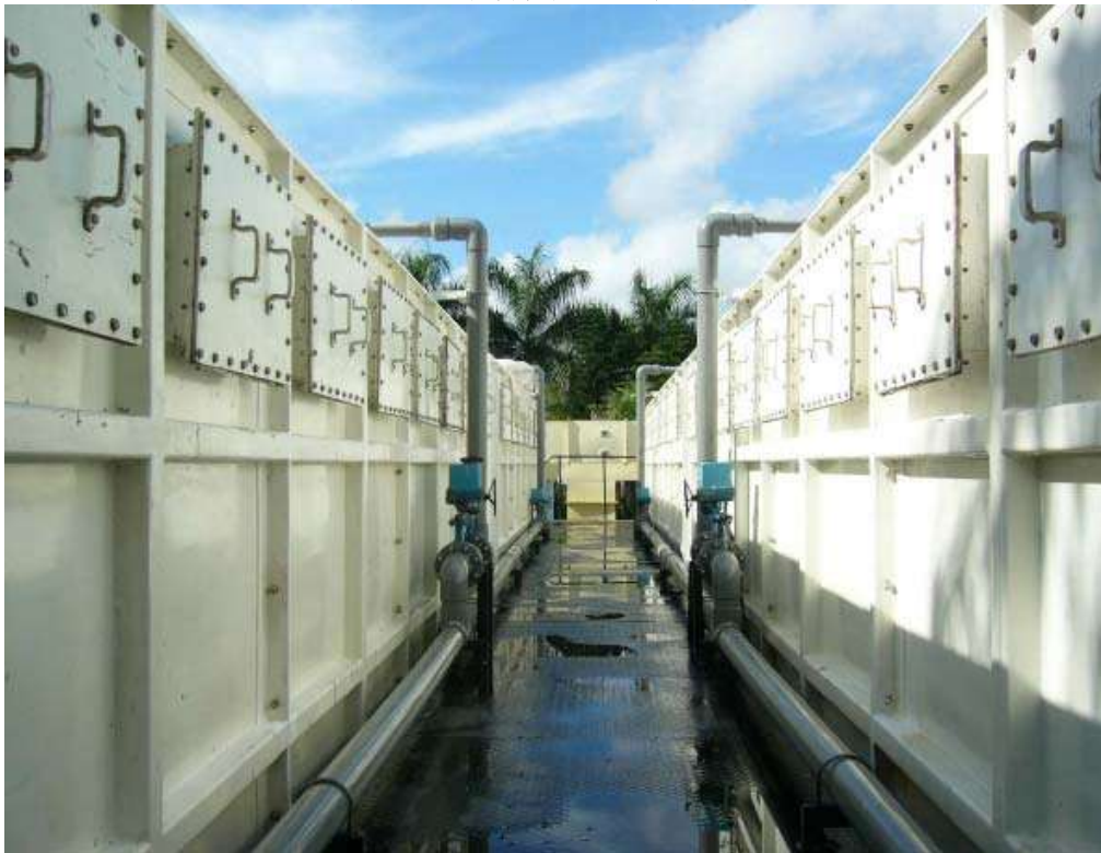
图 9-3 生物除臭实例图
