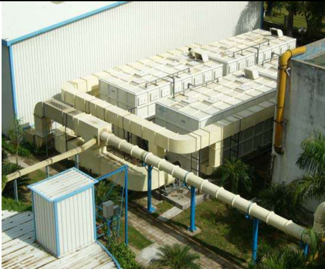
图 9-4 生物除臭实例图
