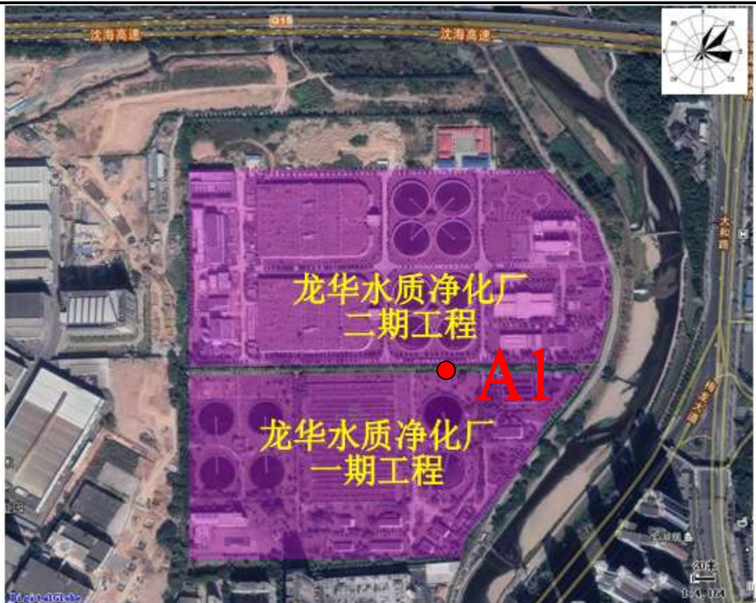
图 8-1 龙华水质净化厂现状
