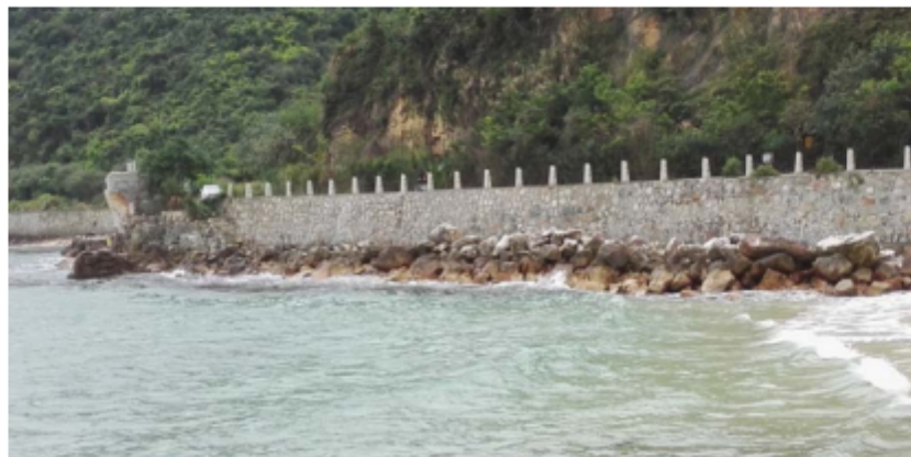
图 1-1 杨梅坑现状海堤
