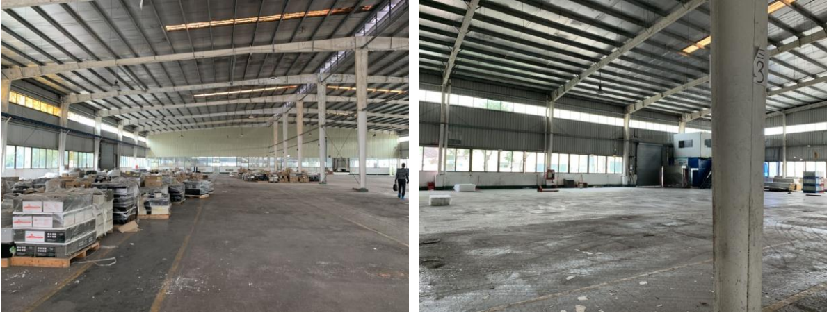
图 1-4 原事业一部（现 1#厂房）现状
