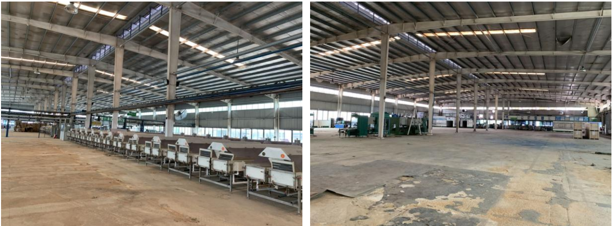
图 1-5 原事业二部（现 2#厂房）现状
