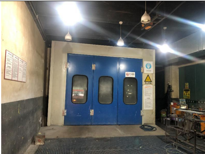
项目密闭车间
