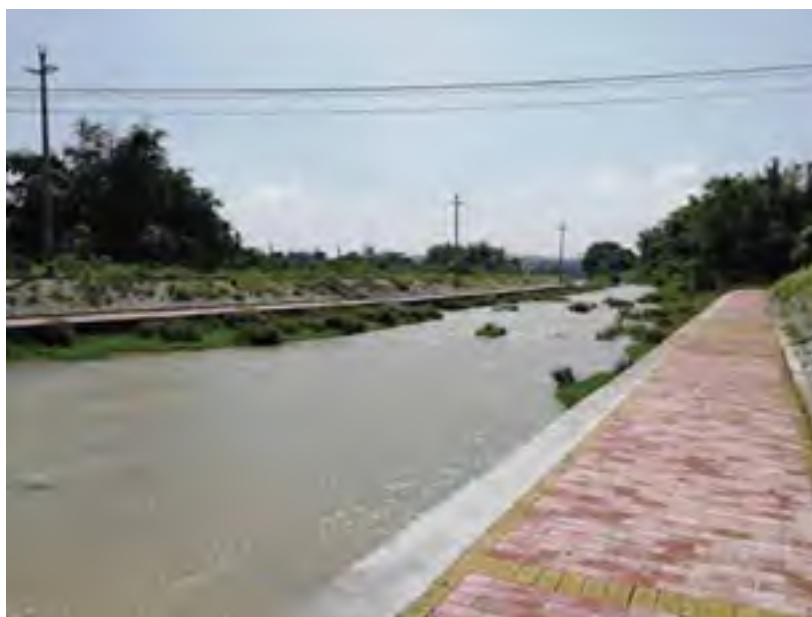
图 3.4-24 高岗村小江河穿越现场图
