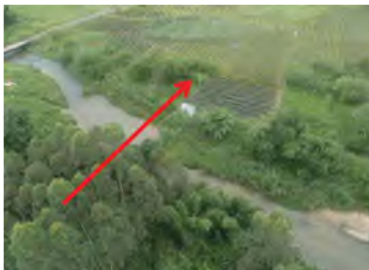
图 3.4-22 琶江支流穿越现场图
