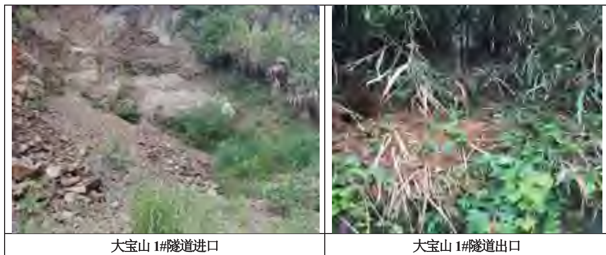
图 3.4-4 大宝山 1#隧道进出口地貌
