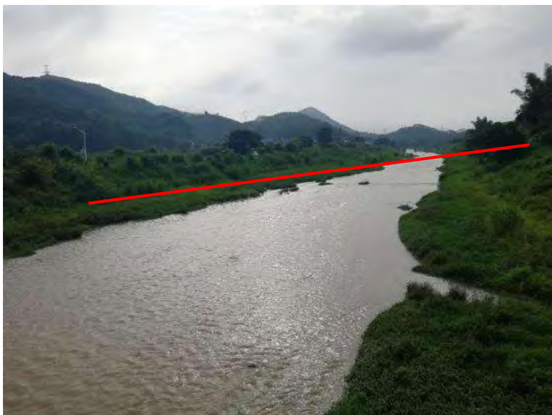
图 3.4-20 琶江汶坑村穿越现场图
