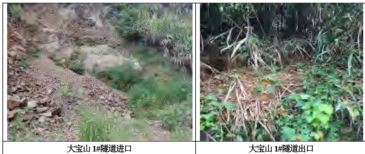
图 3.4-4 大宝山 1#隧道进出口地貌
