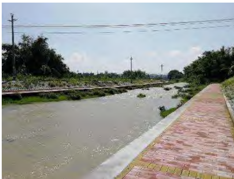
图 3.4-24 高岗村小江河穿越现场图
