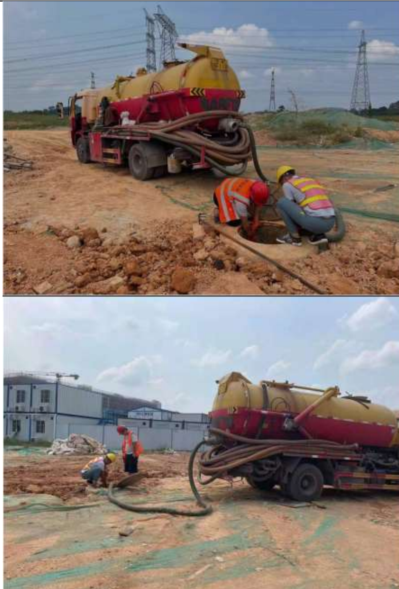
图 7-1 化粪池、隔油池清理
